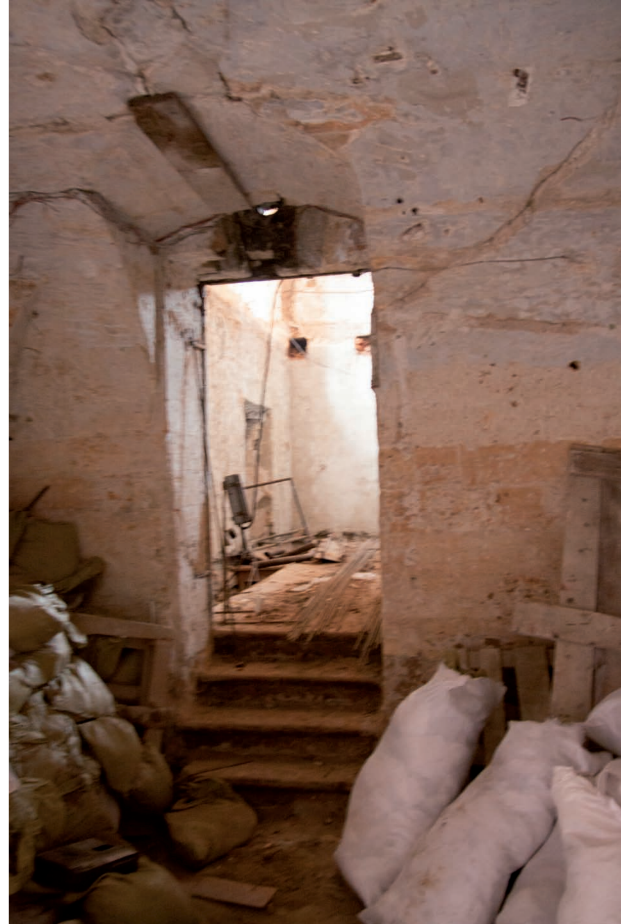
Проход к помещениям на цок. эт. с высоким уровнем потолка / Übergang zu höheren Kellerräumen
