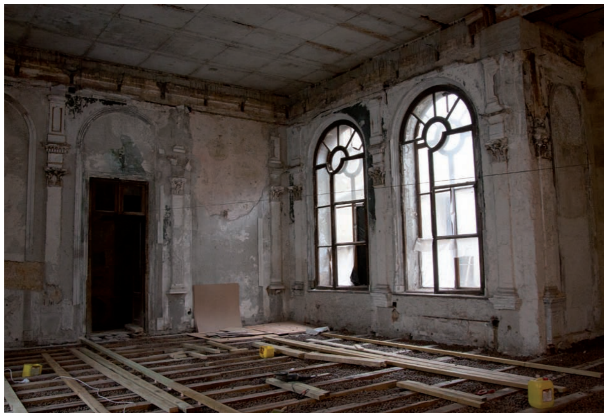
Проход к двухэтажной части здания / Übergang zum zweigeschossigen Bereich
