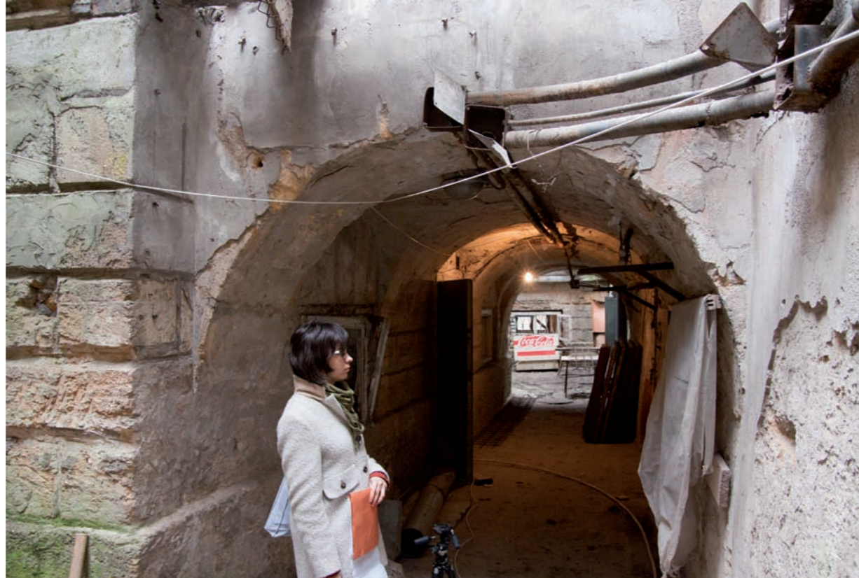
„Распределитель“ цок. эт., сводчатый проход / Verteiler Kellergeschoss, Gewölbegang
