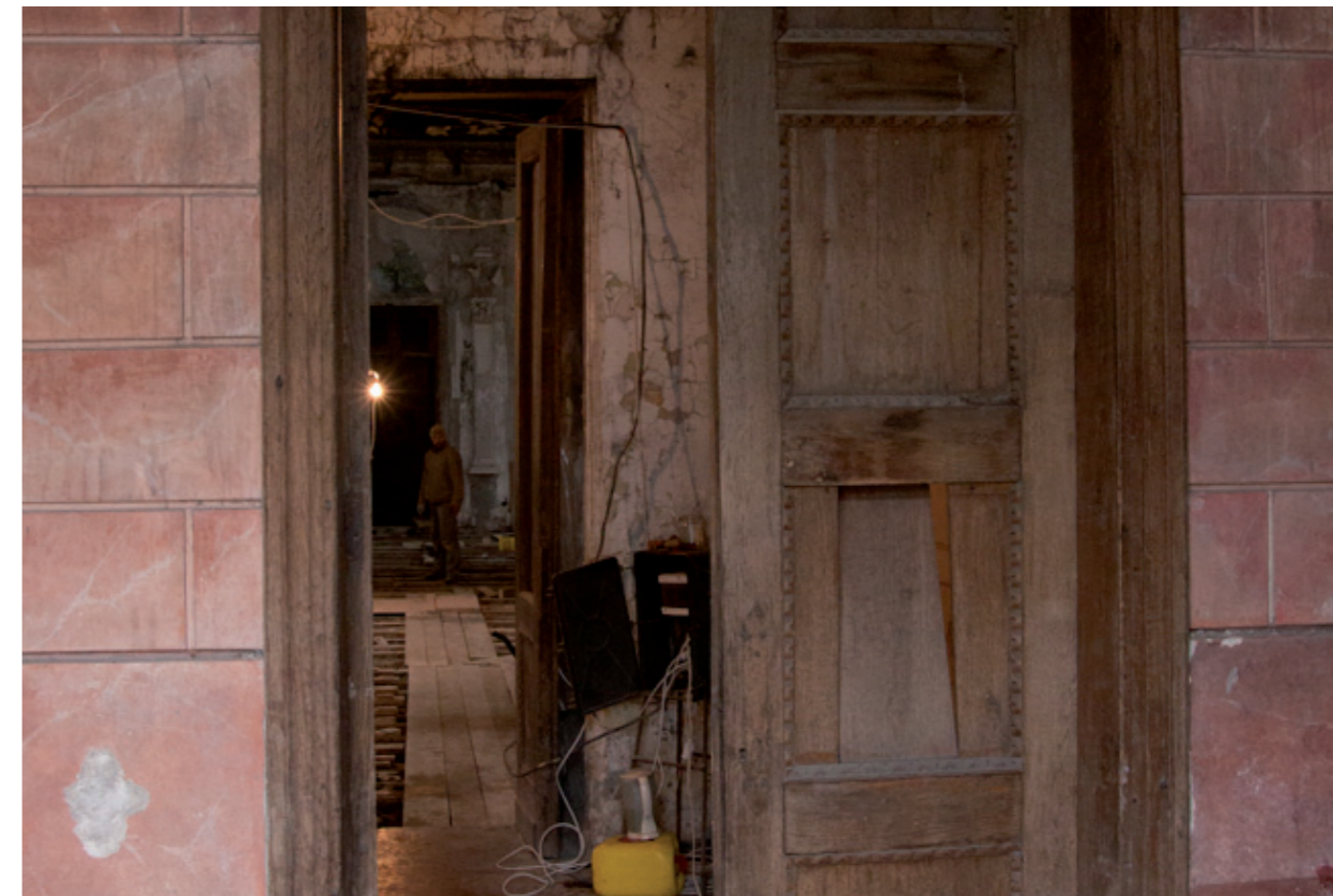
1. Вид со стороны бокового входа / 1. Blick Seiteneingang
