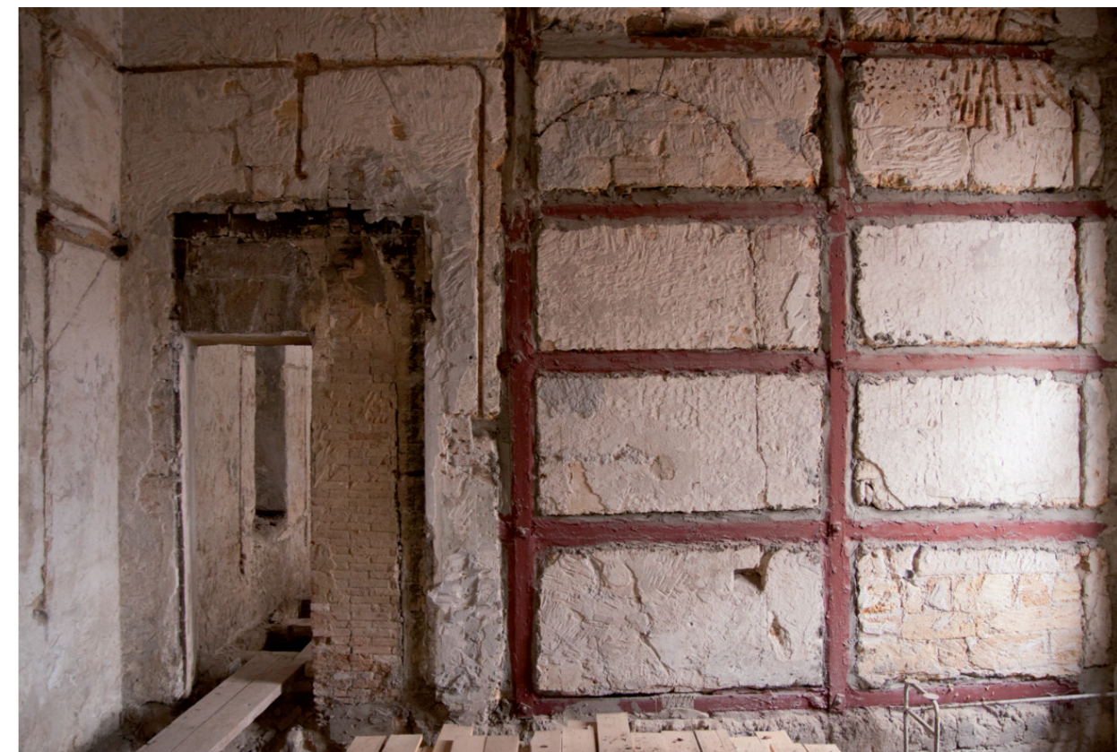
Уменьшенный проход к двухэтажной части здания / Verkleinerter Übergang zum zweigeschossigen Bereich
