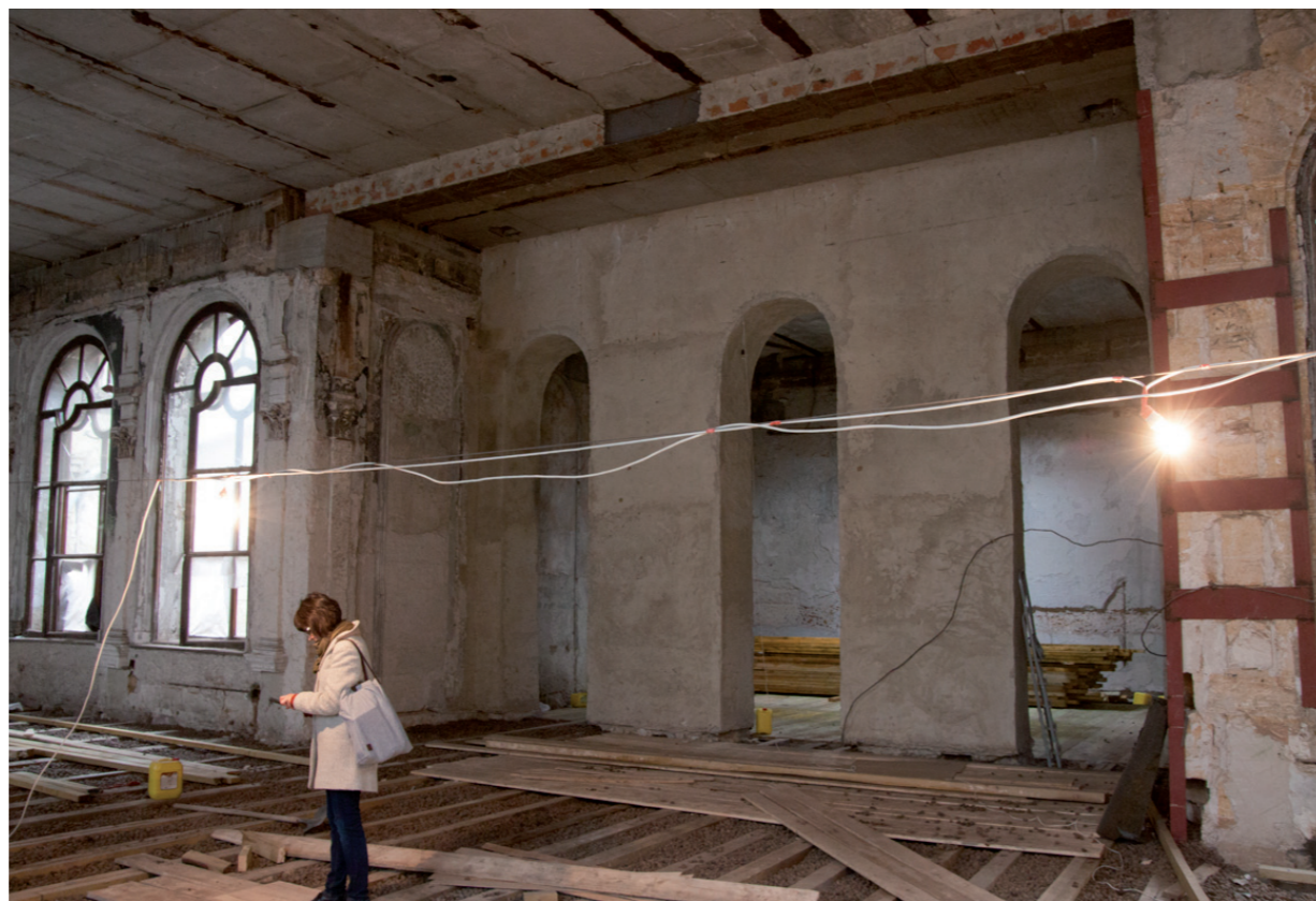
Вид в сторону световых фонарей и прохода в центральную комнату / Übergang zum Zentralraum und Blick in die Lichthöfe
