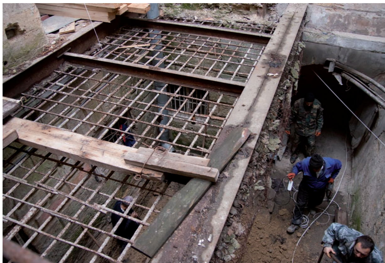
Армированная решетка внутри светового колодца / Armierungsgitter im Lichthof
